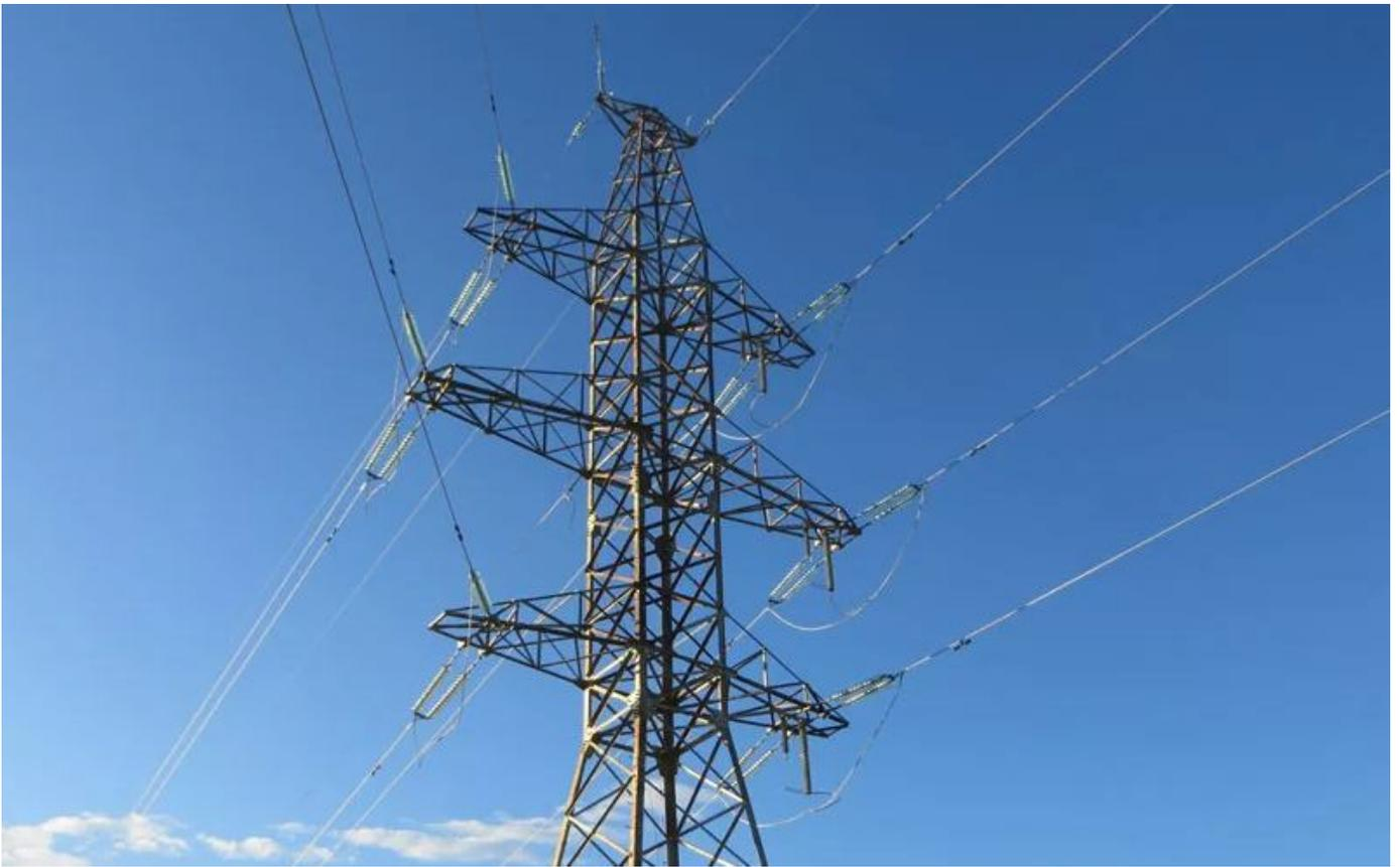
Самые мощные линии электропередач проводят напряжение в 330 кВ, 500 кВ и 750 кВ. Они выглядят массивнее всех предыдущих, на них большие гирлянды изоляторов.
