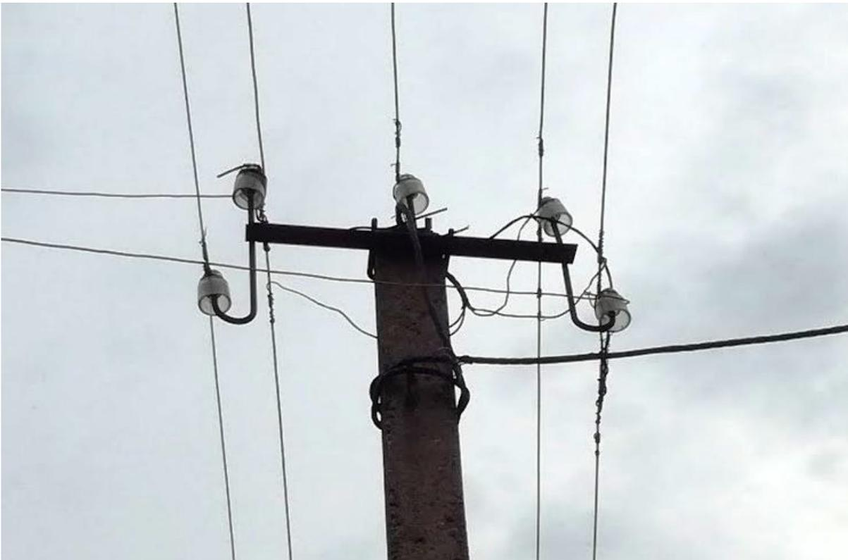
Здесь же устанавливаются высоковольтные линии, обеспечивающие электроснабжение трансформаторов: 6 и 10 кВ (линии в 6 кВ постепенно заменяют другими ЛЭП).
