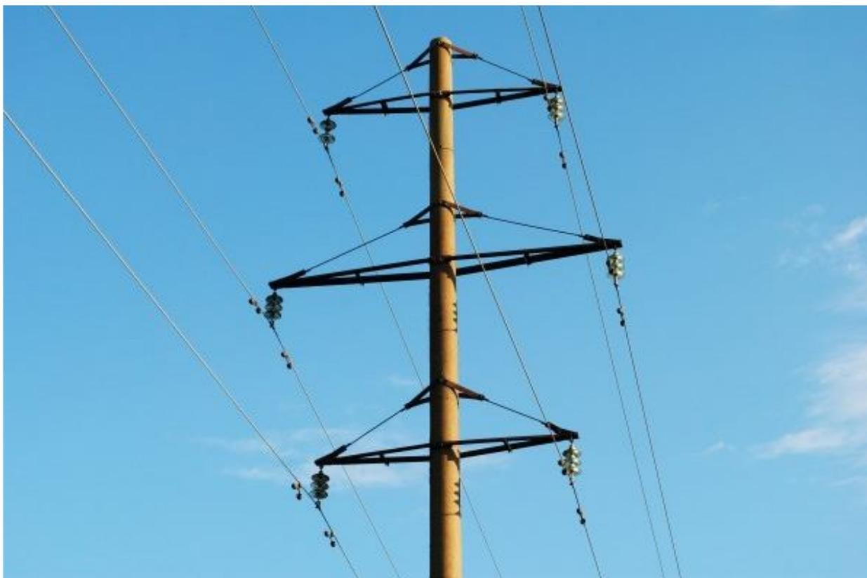
Следом по стандарту идут линии 110 кВ — здесь шесть или восемь больших изоляторов и кабелей.
