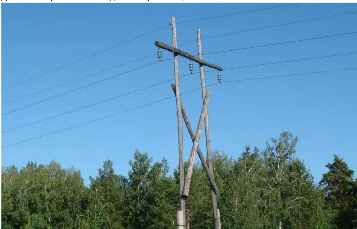
Данные линии имеют три изолятора, к которым подвешено по одному проводу.
