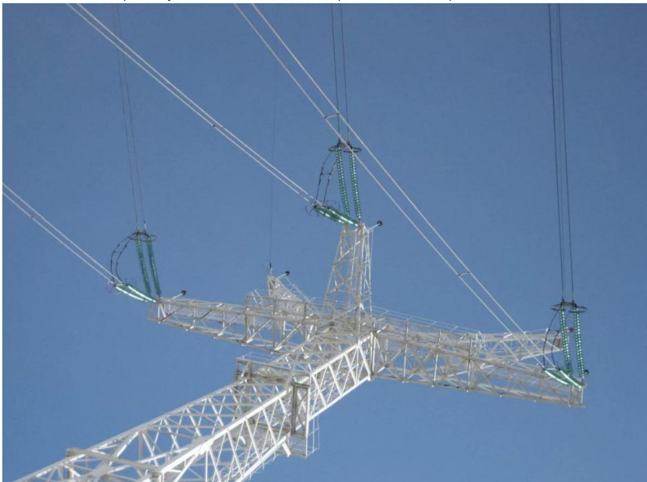
Массивные высоковольтные линии 500 кВ имеют провода, соединенные по трое с гирляндами из 20 диэлектриков.
