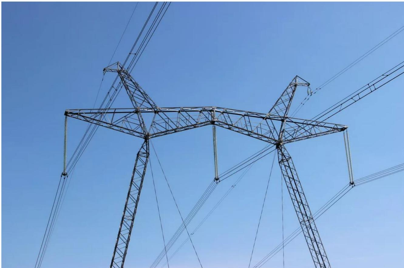
Как убедиться, в том, что Вы правильно определили напряжение? На опорах Вы увидите два ряда: цифры снизу указывают номер опоры, а буква и цифры сверху — номер линии, и в буквенном обозначении — напряжение. На приведенной картинке Т это 35 кВ, также имеются буквенные обозначения С — 110 кВ, Д — 220 кВ.
