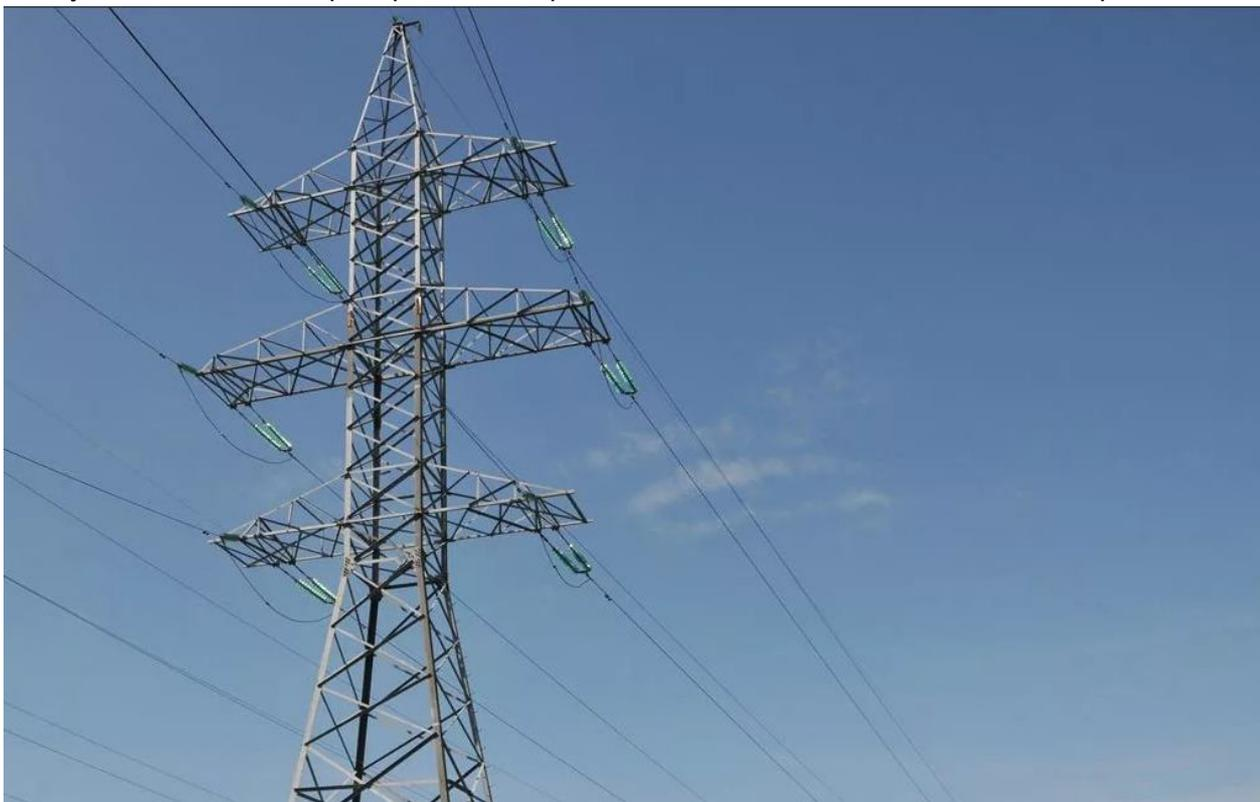
Одни из самых мощных — 220 кВ обычно подводят ток к электростанциям, на них 10-40 диэлектриков, но их легко определить по одному кабелю для одной фазы.
