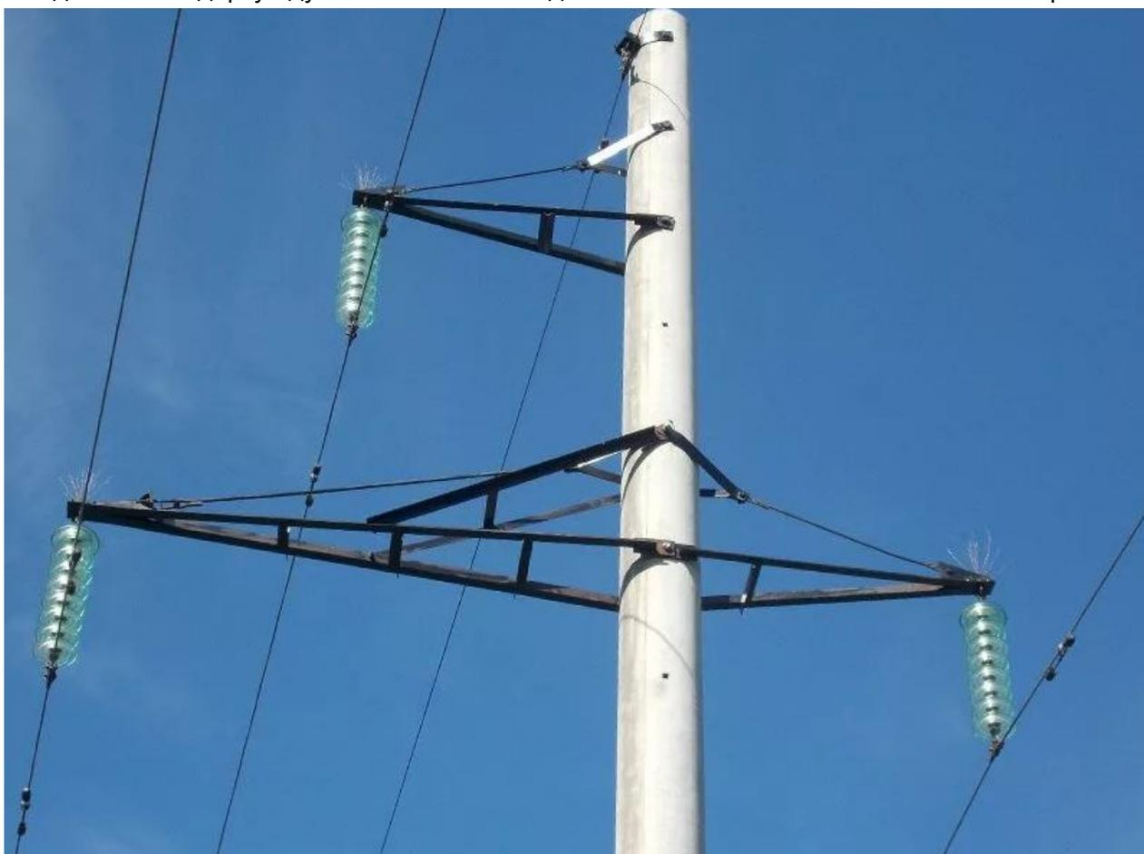
Воздушные линии электропередач с напряжением в 150 кВ имеют по 8-9 диэлектриков.
